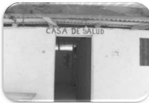
Fig.15. Estado de la infraestructura de las casa de salud. Fuente: Diagnóstico municipal participativo 2008
