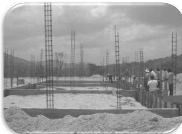
Fig. 14 Construcción de la Escuela Primaria 21 de marzo de Macahuitera
