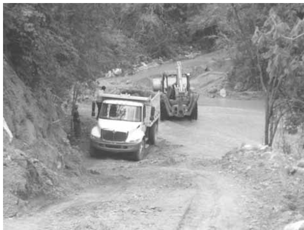
Fig. 16. Maquinaria del municipio.
