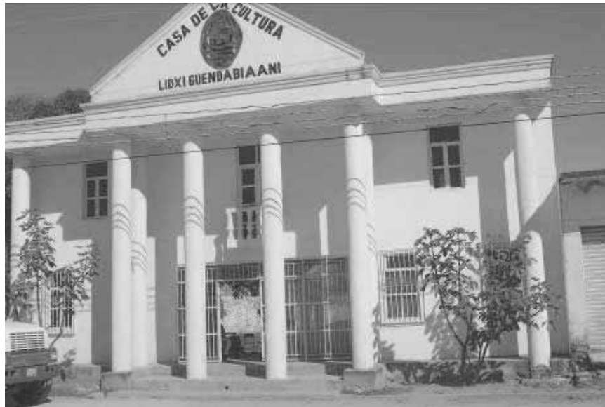
Figura 11: Casa de la Cultura, Unión Hidalgo, Juchitan, Oaxaca. Fuente: PROPIA
