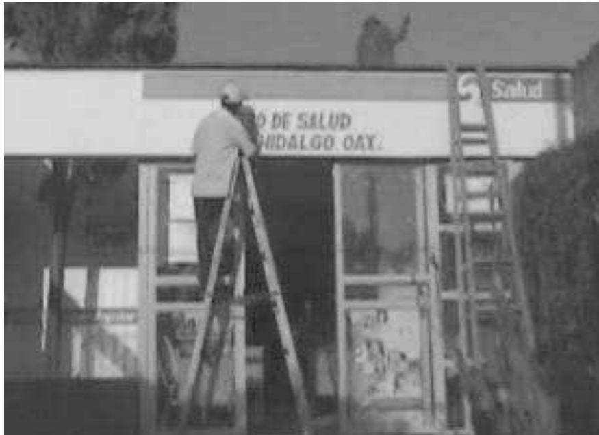
Figura 9: Centro de Salud, Unión Hidalgo, Juchitan, Oaxaca. Fuente: PROPIA
