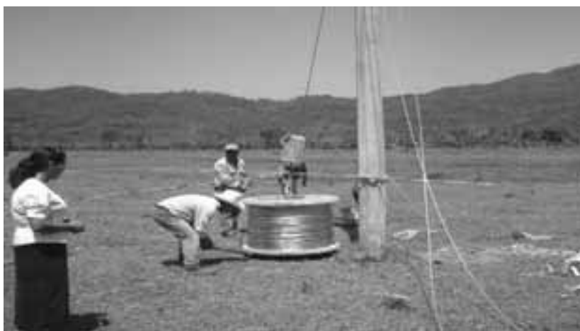
La Figura No 5 Cambio de un poste de luz que fue dañado por las lluvias.
