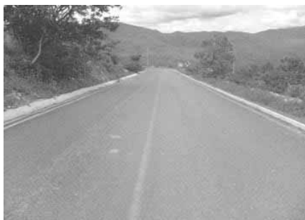
Figura 13: Carretera asfaltada de Yutanduchi de Guerrero 5 km
