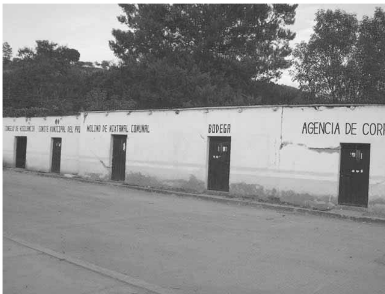
Foto 1: Oficinas y bodega del municipio de Zapotitlán del Río.
