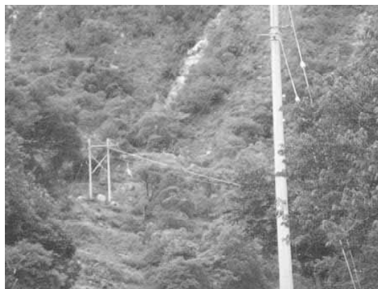
Foto 10. Sistema de electrificación que esta en proceso de introducción en la localidad Benito Juárez el Zapote
