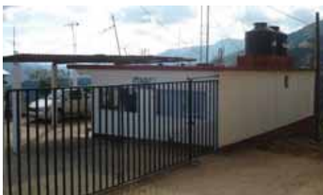
Figura 11. Infraestructura de la Clínica en la Cabecera Municipal.
