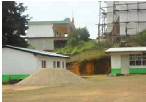
Figura 9. Infraestructura de la Escuela Primaria de la Agencia de policía de Zompantle.
