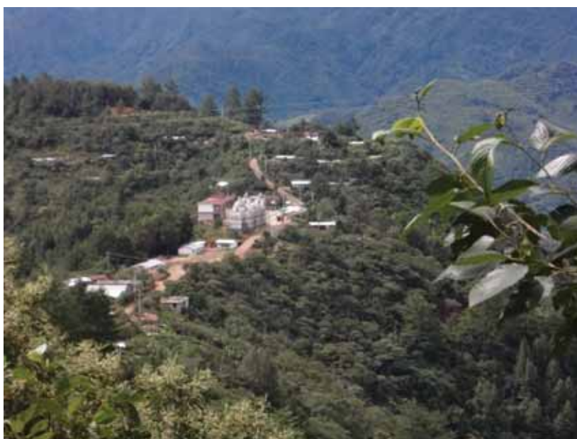
Figura 22. Obra negra de la agencia de policía de Zompante.
