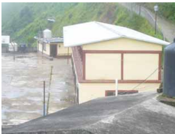
Figura 5. Infraestructura de la Escuela Primaria en la Cabecera Municipal.
