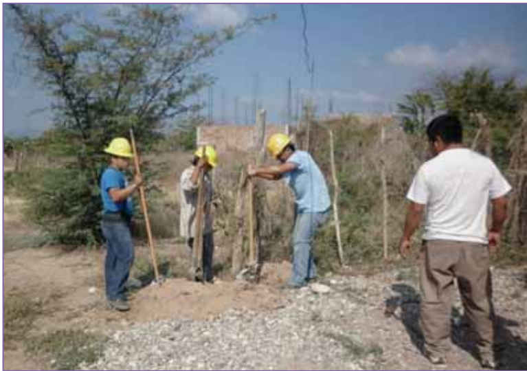
Ampliación de la red de energía eléctrica
