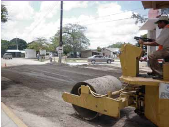
Pavimentación de calles
