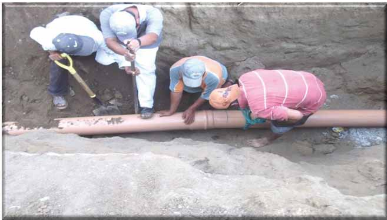
Imagen 30.- Ampliación y rehabilitación de servicios básicos para brindar calidad a los usuarios
