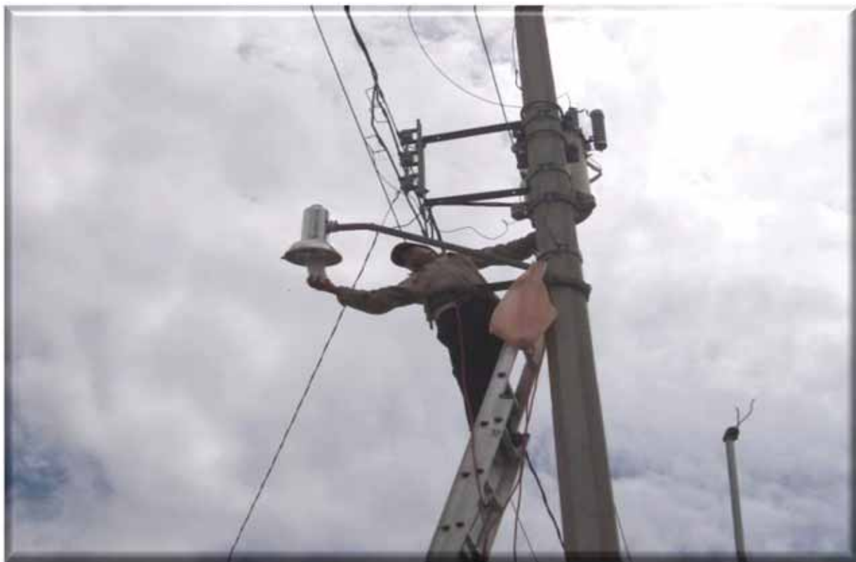
Imagen 31.- Mantenimiento al alumbrado público de la cabecera municipal
