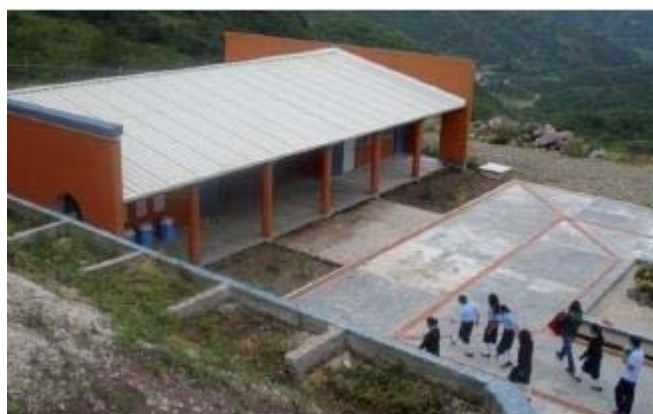
Foto 7. Instalaciones del BIC
