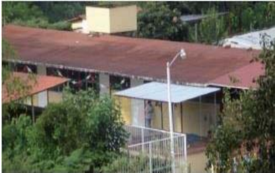
Foto 3. Instalaciones de la escuela primaria en Guelatao de Juárez.
