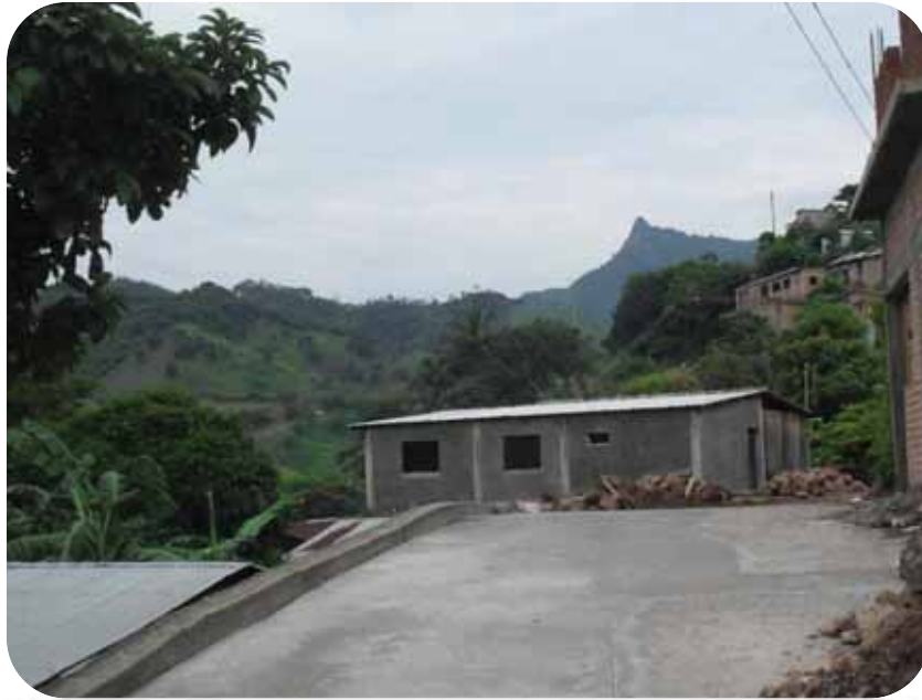
TERMINADO DE PAVIMENTACION DE CALLES DE GUEVEA, AL FONDO EL PICACHO.
