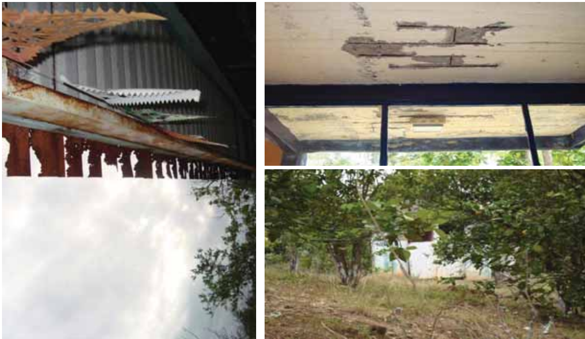
Foto 2 - 10 Techumbre corroída, techo deshabilitado y baños en malas condiciones, escenario propio de construcciones y accesorios de escuelas primarias del municipio de Matías Romero Avendaño, Oax.
