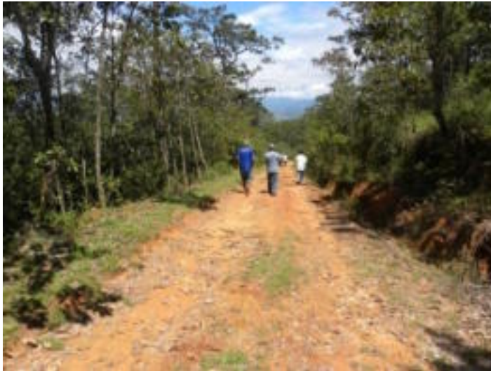
Figura 20.- Caminos de terracería del Municipio de Putla Villa de Gro.
