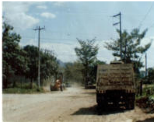
Figura 35.- Motoconformadora y retroexcavadora
