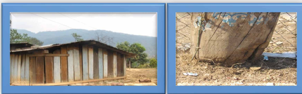
Foto 5: Vivienda de la Esperanza sin energía eléctrica y postes de luz en malas condiciones.
