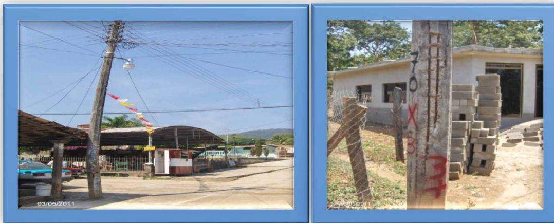
Foto 4. Postes de luz en mal estado en el Centro de la Reforma.
