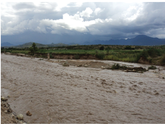
Foto 3. Desbordamiento del rio atoyac se requiere de bordarlo nuevamente.
