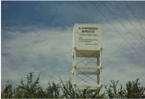
Foto 9. Tanque de agua potable el fresno.
