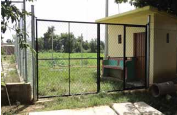
Foto 3. Pozo de agua potable "la freznera".
