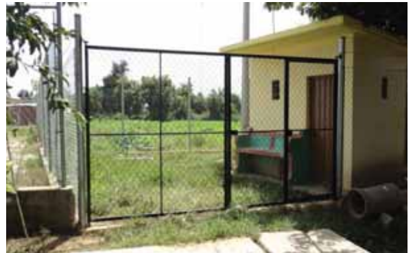
foto 12 Pozo de agua Potable la freznera.
