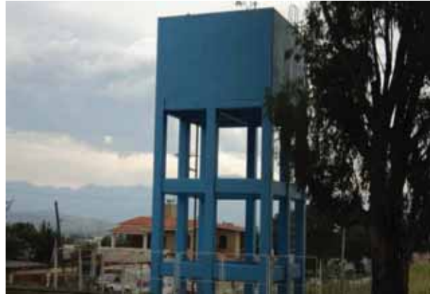
Foto 10. Tanque de agua la freznera.
