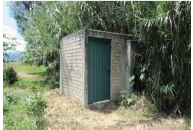
Foto 22. Pozo de agua potable "la cienega".
