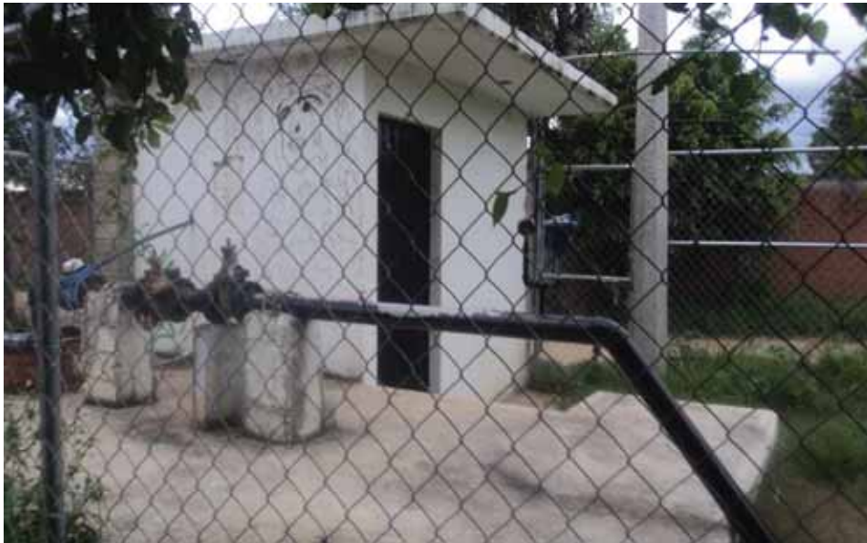
Foto 5. Pozo de agua potable "los fresnos".
