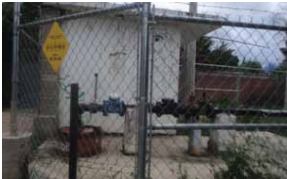
Foto 11. Pozo de agua potable los fresnos
