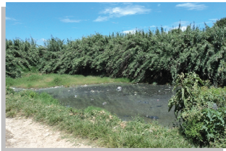
Foto 5. Fosa de Oxidación, y paraje donde se construirá la planta tratadora de aguas residuales.
