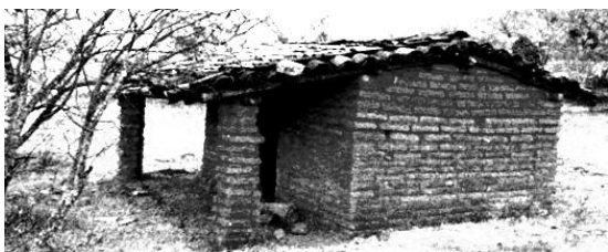
FIG. 15: CASA DE ADOBE
