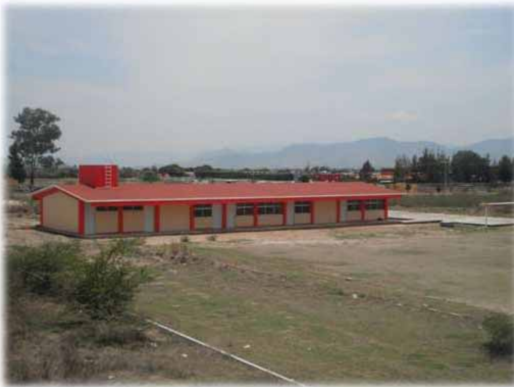
Fotografía 5. Infraestructura COBAO en cabecera municipal
