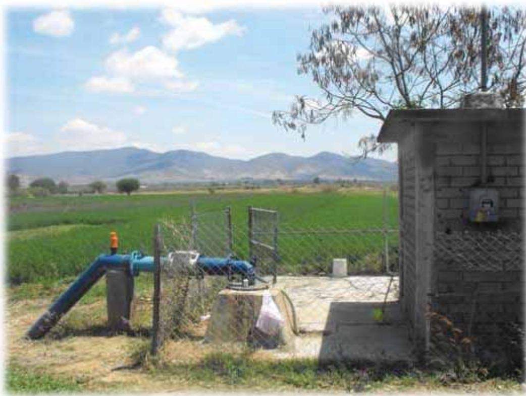
Fotografía 9. Infraestructura productiva – pozo profundo
