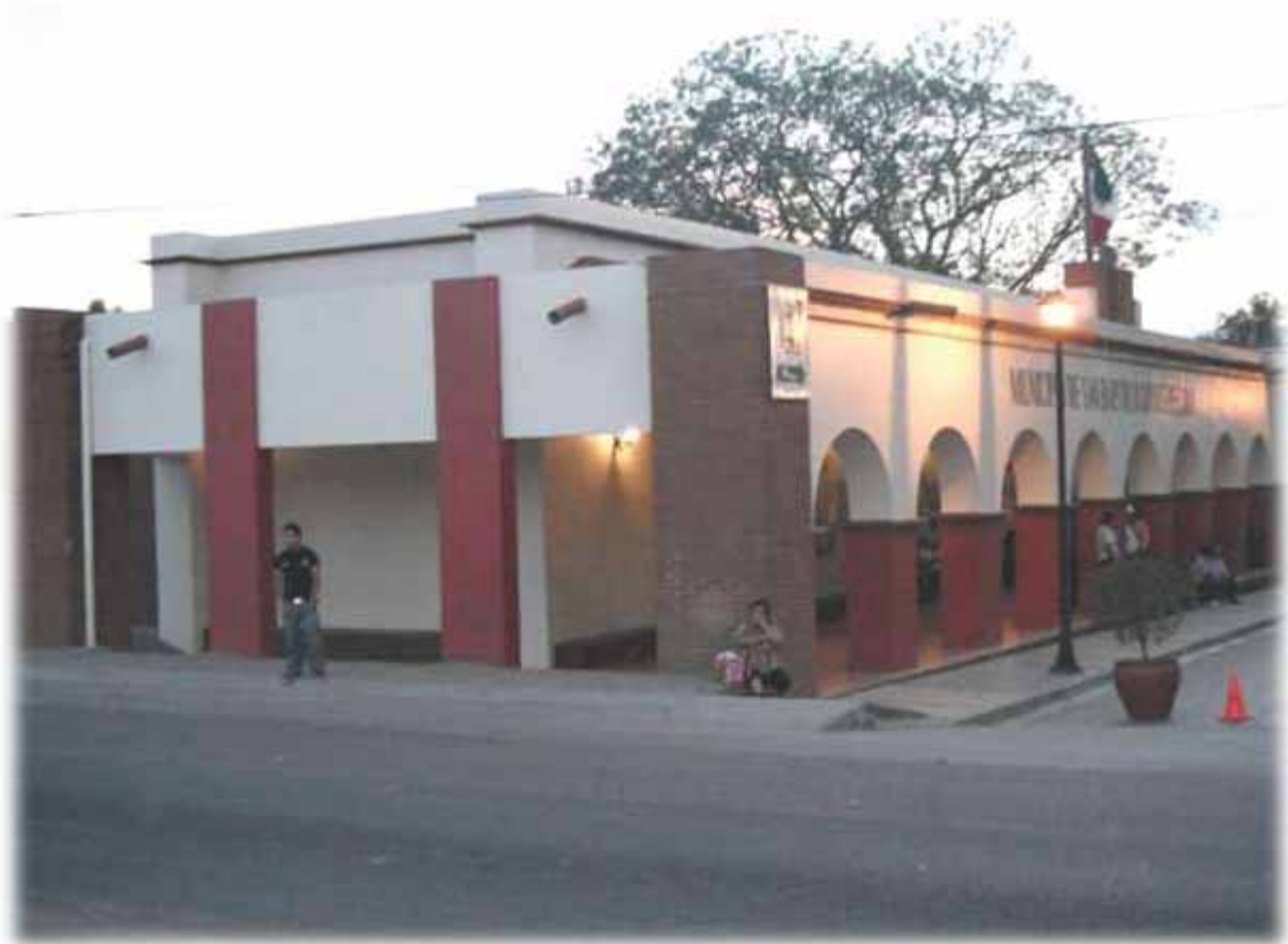
Fotografía 10. Fachada del edificio municipal
