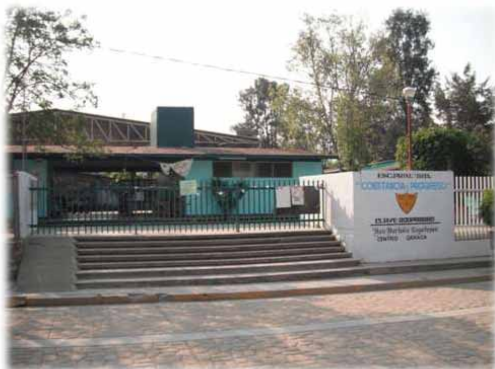
Fotografía 3. Infraestructura escuela primaria en cabecera municipal
