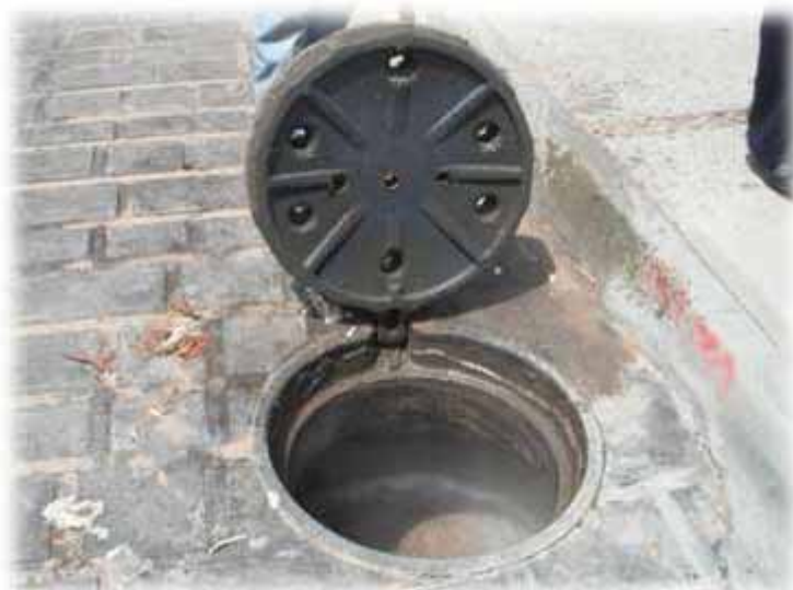
Fotografía 7. Infraestructura de drenaje – compuerta de servicio
