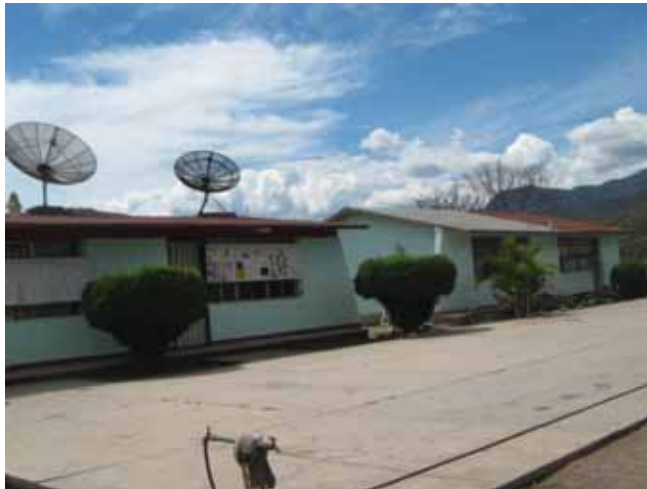
Figura 12 Instalaciones del IEBO de San Bartolo Yautepec.
