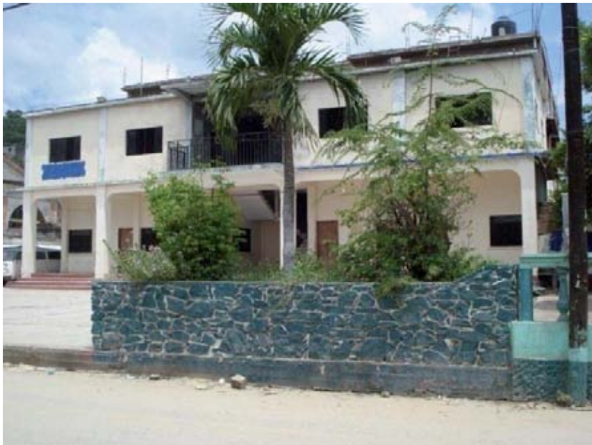
Foto 16.- Instalaciones del palacio municipal.
