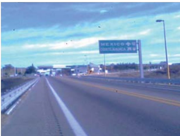
SUPERCARRETERA QUE COMUNICA A LA CD. DE OAXACA CON LA CIUDAD DE MEXICO. CASETA DE COBRO NO. 78, KM. 141 + 223
