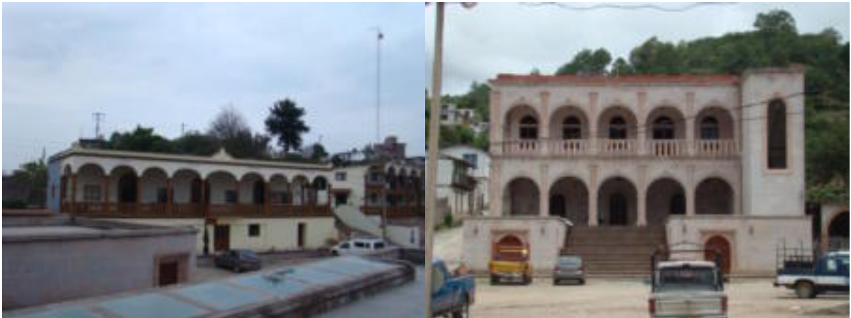
Figura 26. Palacio municipal (actual y nuevo)
