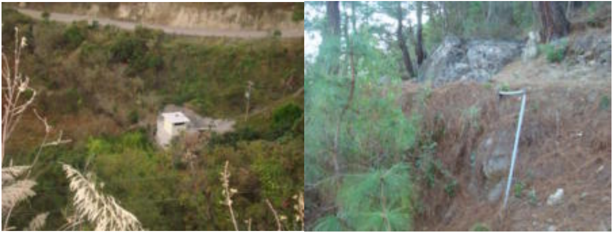
Figura 17. Tanques de almacenamiento de agua potable
