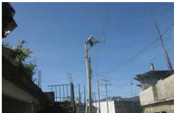
Mejoramiento de la red eléctrica
