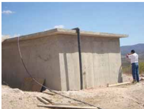
Figura 111. Tanque de almacenamiento sección segunda.
