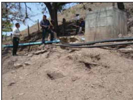
Figura 42. Línea de conducción de agua del nacimiento al tanque de almacenamiento.
