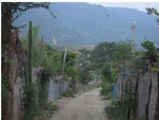
Figura 40. Electrificación en la segunda sección.
