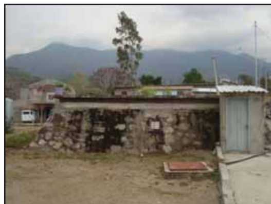
Figura 43. Tanque de almacenamiento de agua ubicado en la sección tercera.
