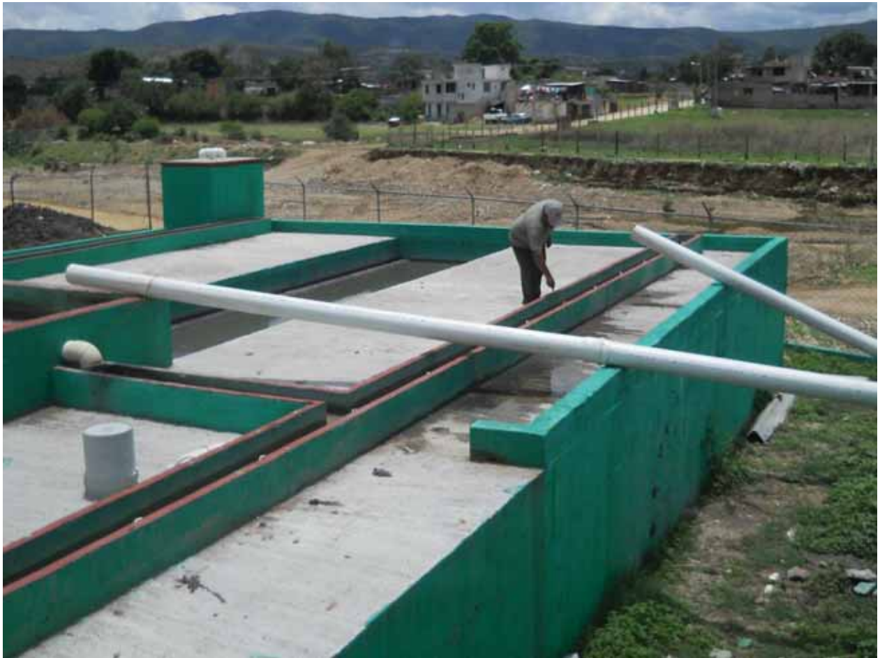
Ilustración 6. Planta de tratamiento de aguas residuales de la población de San Francisco Telixtlahuaca, Oax.
