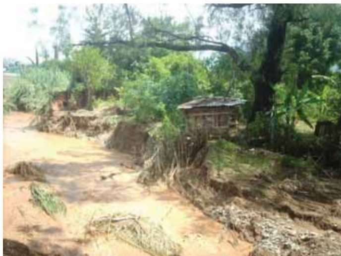
Desbordamiento del Arroyo Sapo, Septiembre 2010, generando inundaciones en Las Colonias Los Pinos, Cuauhtémoc Cárdenas, Granjas y Huertos.
