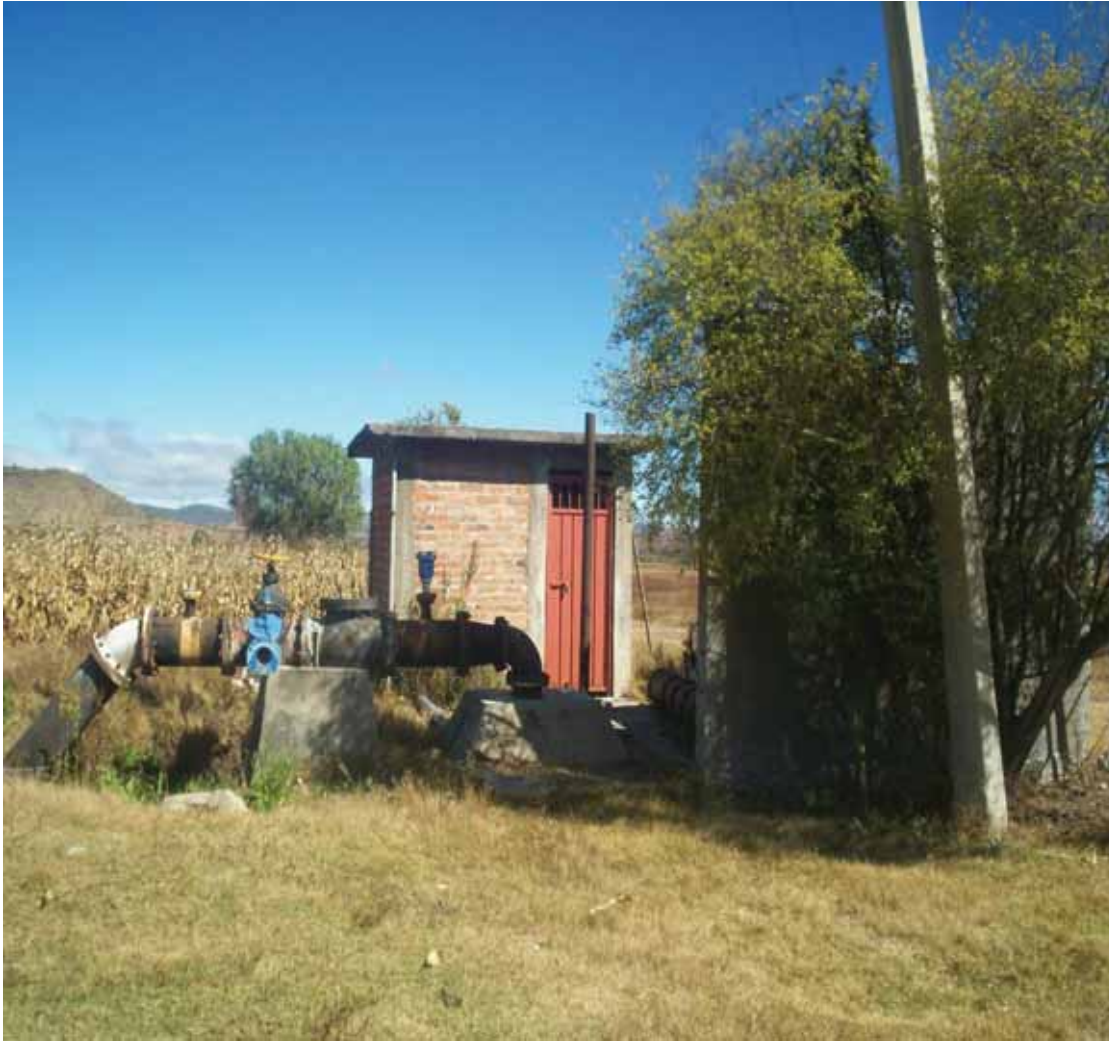
Pozo semi profundo para abasto de agua potable
