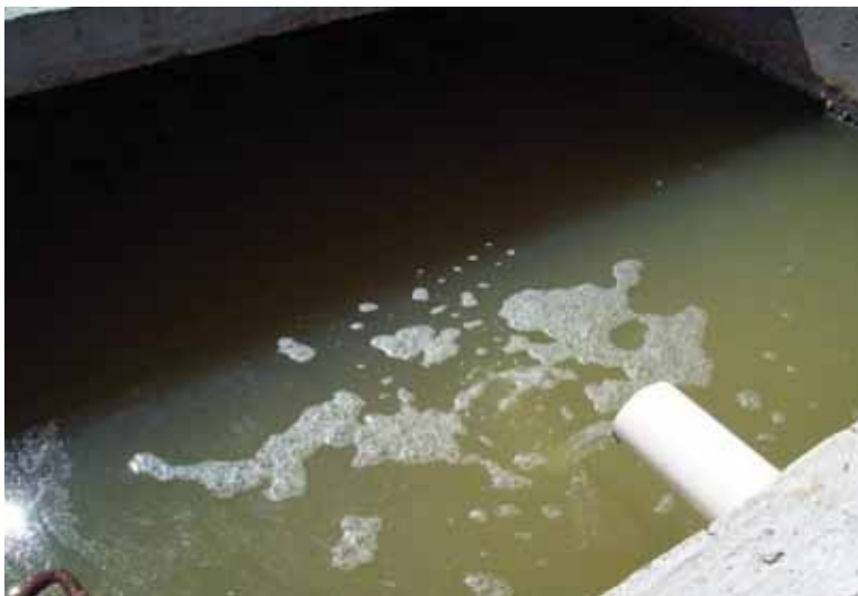
Foto: Agua de la red de drenaje que desemboca en la planta de Aguas Residuales para su tratamiento.
