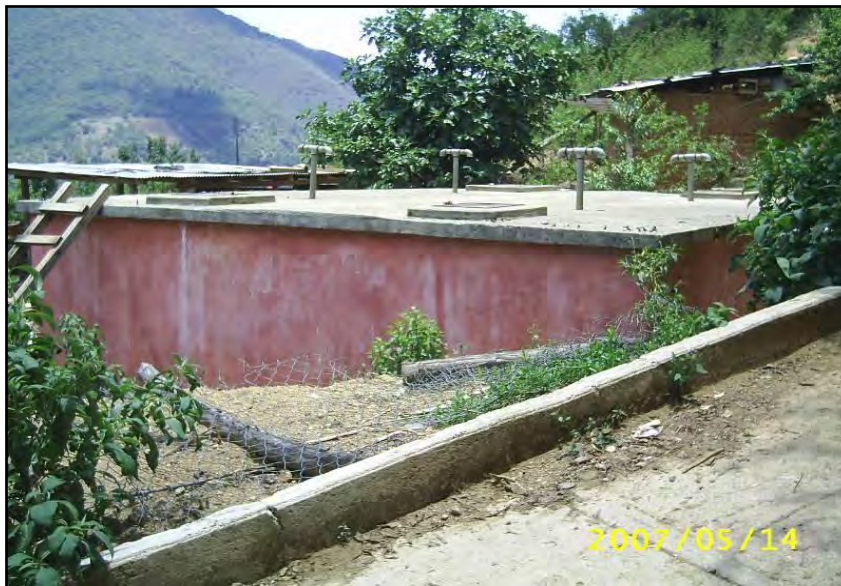
Tanque de almacén de agua potable.
