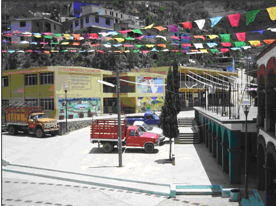
Vista al fondo de la infraestructura escolar de educación primaria.
