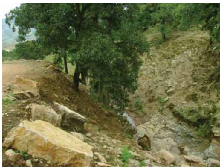
EROSION DEL SUELO 1
