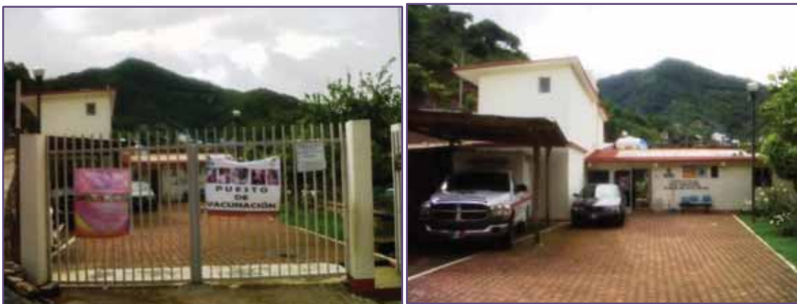
Fachada e interior del Centro de Salud de San Miguel Mixtepec
