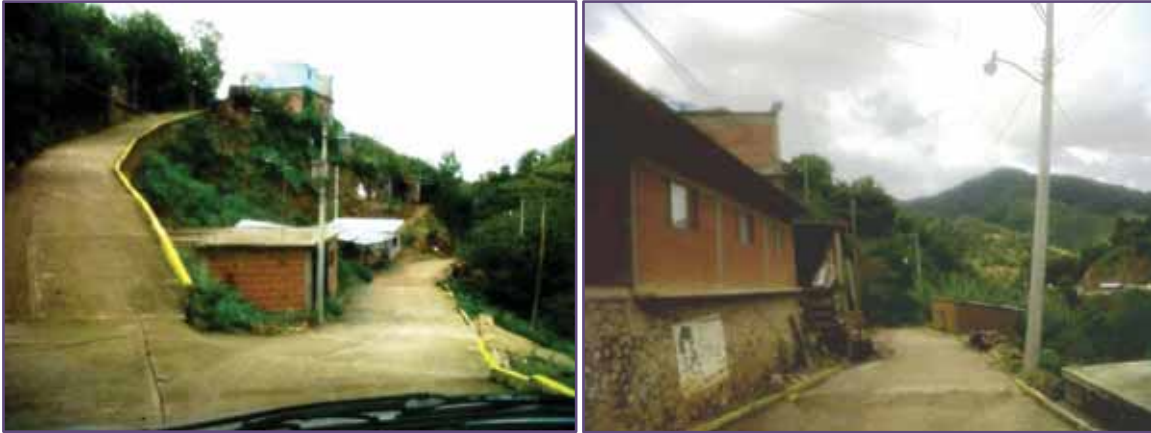
Infraestructura eléctrica para uso habitacional y alumbrado público en San Miguel Mixtepec
