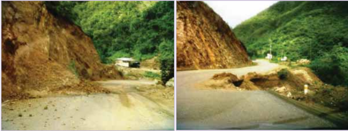
Deslaves y derrumbes en la carretera hacia San Miguel Mixtepec
