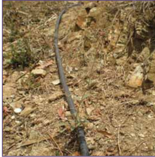
Tubería para abastecer agua potable a San Miguel Mixtepec
