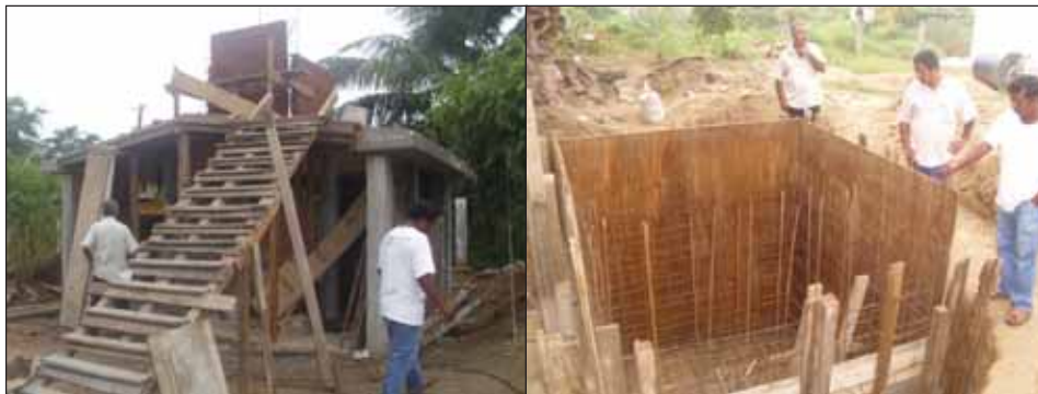
Figuras 12 y 13) Construcción de baños y sistema para una Escuela del Zapote
