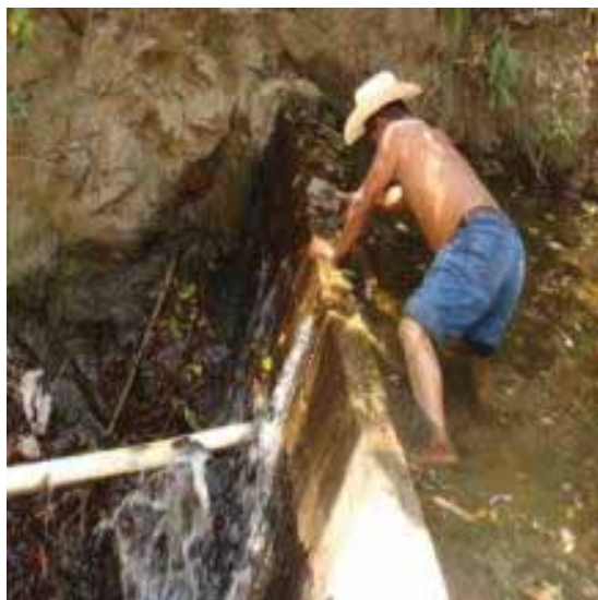
Foto 13: Sistemas de captación de agua y líneas de conducción muy deterioradas
