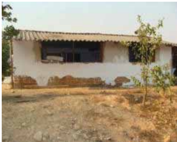
Foto 12: Aula en mal estado de preescolar en la que se imparten clases
