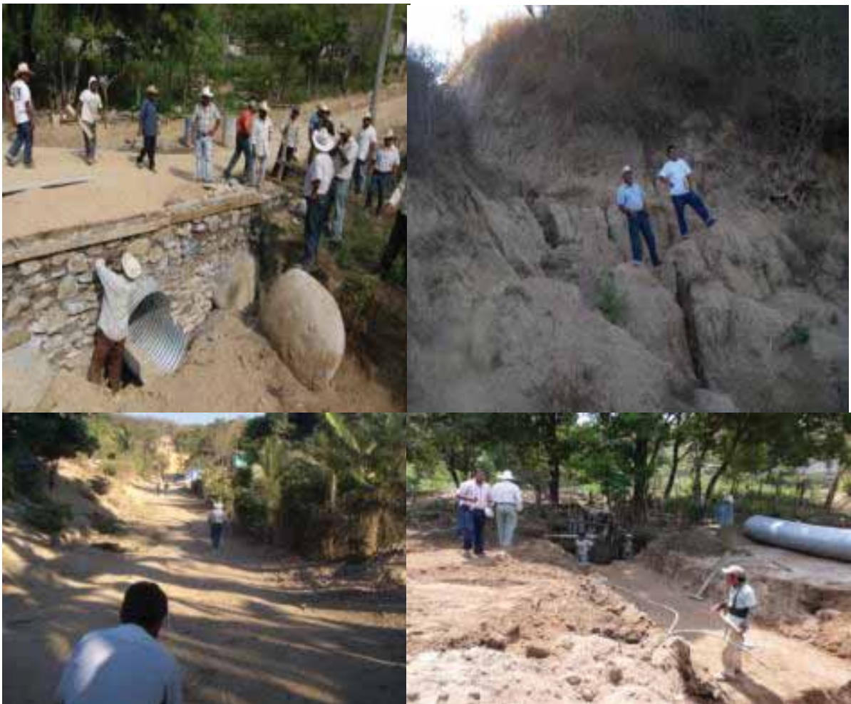
Foto 14-15: Necesidades de pavimentación de calles con dificultad por la orografía.
