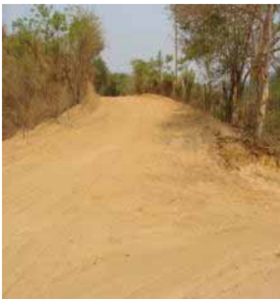
Foto 17: Carreteras de Terracerías
