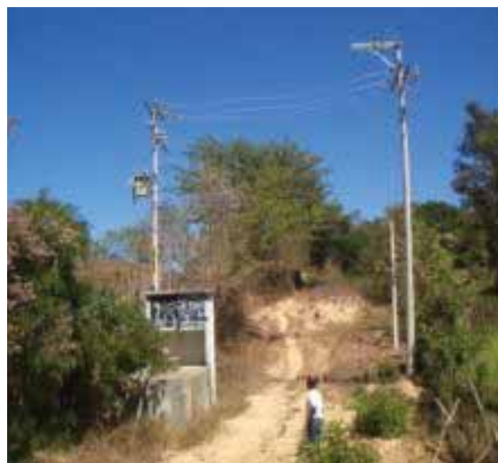
Foto 11: Introducción de energía eléctrica a colonias y barrios
