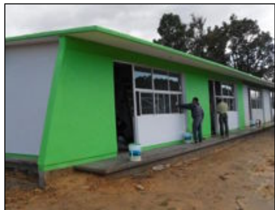
Foto 2: Aulas Construidas en el 2011.
