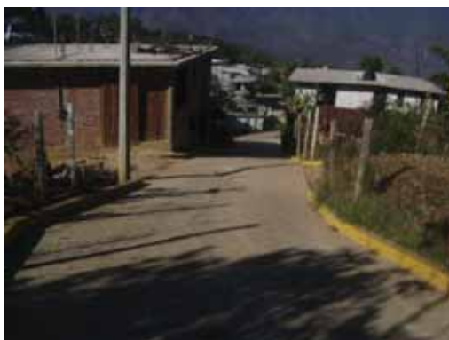
Pavimentación San Martín Buena Vista
