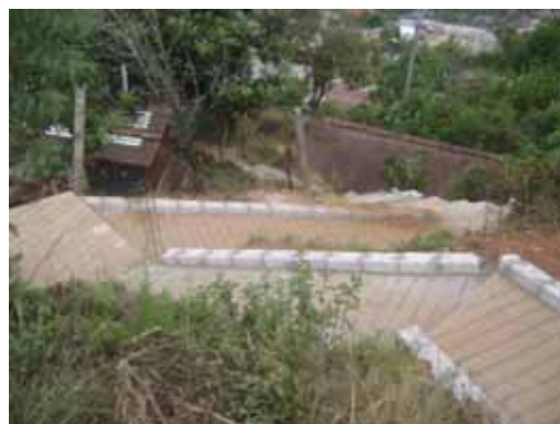
Acceso peatonal San Pedro Yolox.
