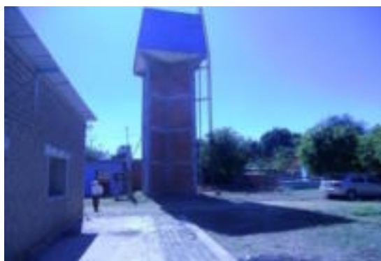
Tanque de almacenamiento de agua potable en la cabecera municipal.
