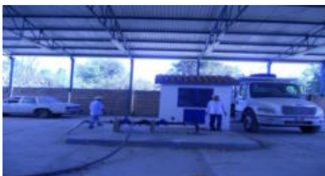
Equipo de bombeo ubicado en la cabecera municipal.
