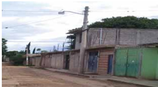
Condición actual del alumbrado publico
