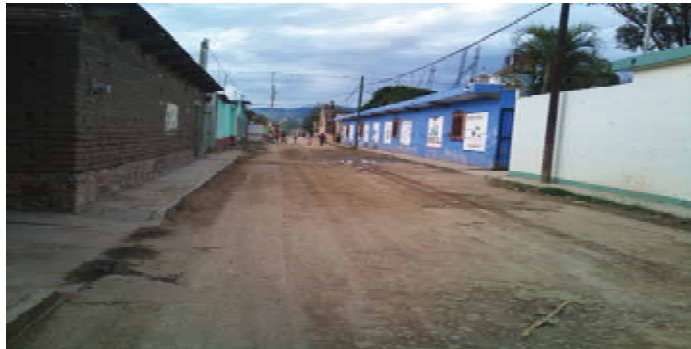
El 90 % de las calles no están pavimentadas
