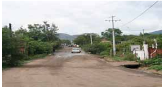
Carretera principal que conduce a la población en muy malas condiciones
