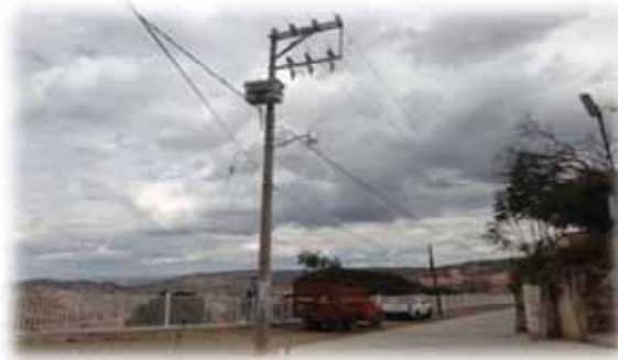
Figura 1. Infraestructura de energía eléctrica
