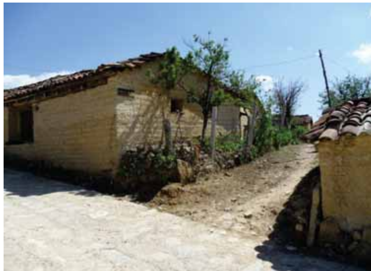
VIVIENDAS CONSTRUIDAS CON MATERIALES TRADICIONALES
