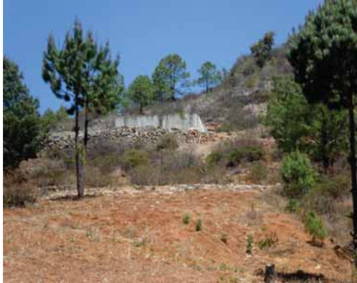
TANQUE DE AGUA
