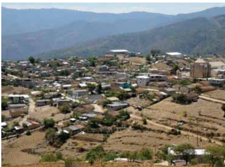
LA MAYORIA DE CALLES DE LA POBLACION ESTAN SIN PAVIMENTAR
