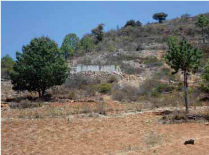
TANQUE DE ALMACENAMIENTO DE AGUA POTABLE
