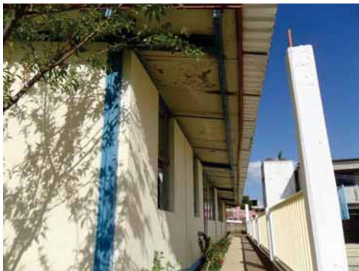
TECHUMBRE DE AULAS EN LA TELESECUNDARIA EN MAL ESTADO
