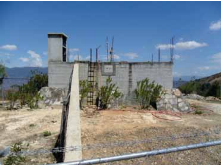
TANQUE DE AGUA
