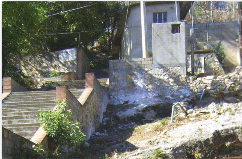
Fotografía 4. Suministro de agua
