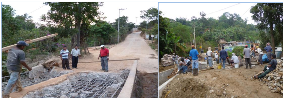
Foto No. 1. Construcción del puente del Rio vallisto.
