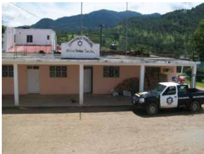
Fotografía 12: Comandancia Municipal. Fuente: Recorrido de campo.
