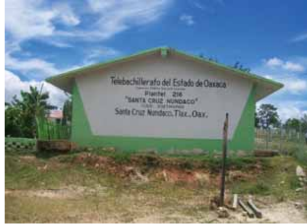
Fotografía 4: Infraestructura de Telebachillerato. Fuente: Recorrido de campo.
