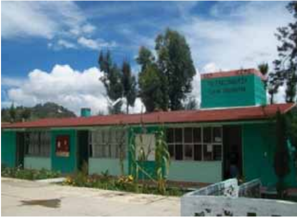
Fotografía 3: Infraestructura de Telesecundaria. Fuente: Recorrido de campo.
