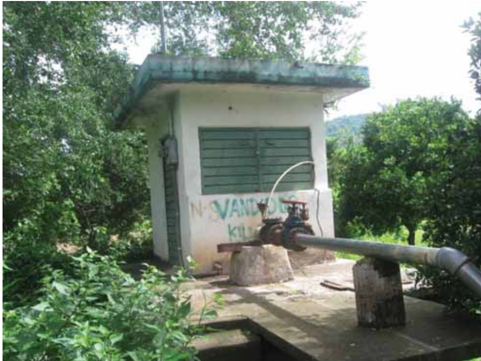
Ilustración 38. Pozo de Agua Potable.
