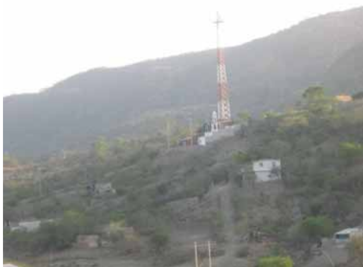
Ilustración 15. Antena de servicio de telefonía celular.
