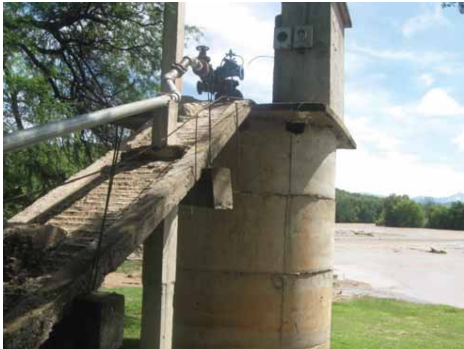
Ilustración 39. Pozo de Agua Potable
