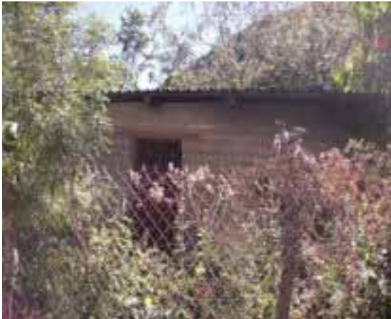
Tipo de vivienda que prevalece en el municipio
