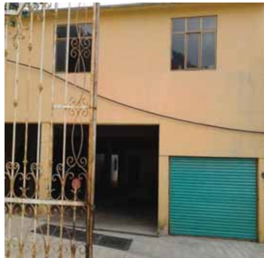
Foto 17: Estacionamiento y salón de usos múltiples.
