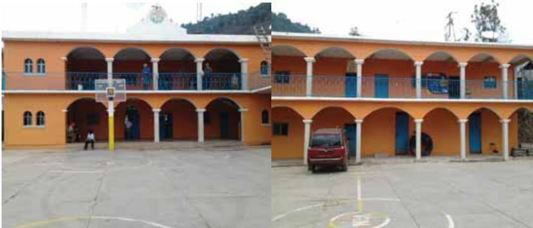
Foto 15: Instalaciones del Palacio Municipal.
