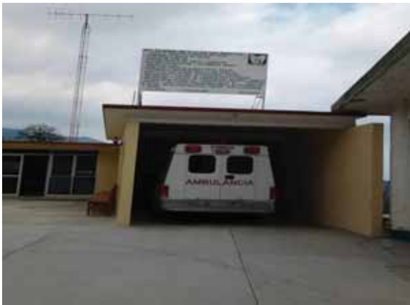
Foto 11: Estacionamiento de ambulancia.- instalaciones de la Unidad Médica del IMSS.
