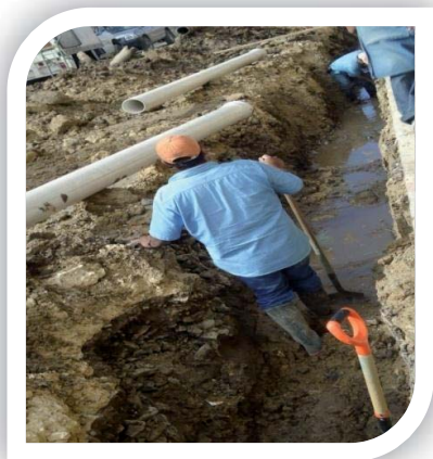
Imagen: 17 Reparación de tuberías de agua potable.
