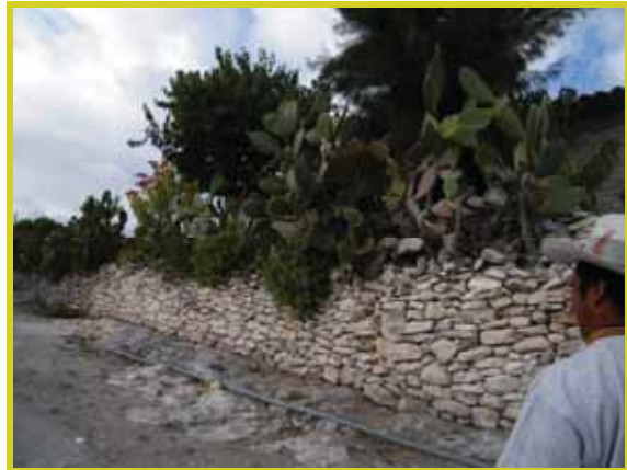
Aspecto de la red de agua potable
