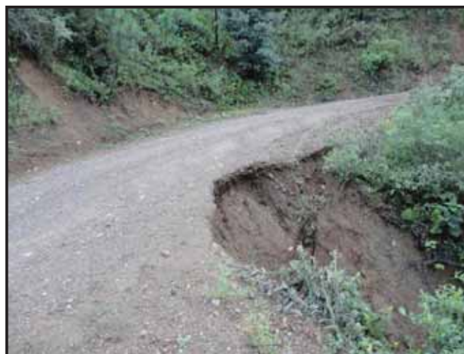
Figura 6. Camino de terracería rumbo a Santa María Quiépolani en mal estado
