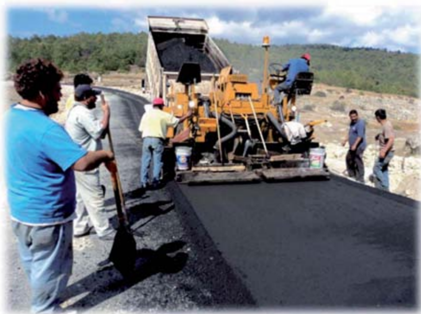
Imagen 27. Inicia la pavimentación del camino Stgo. Yosondua–Santa María Yolotepec.
