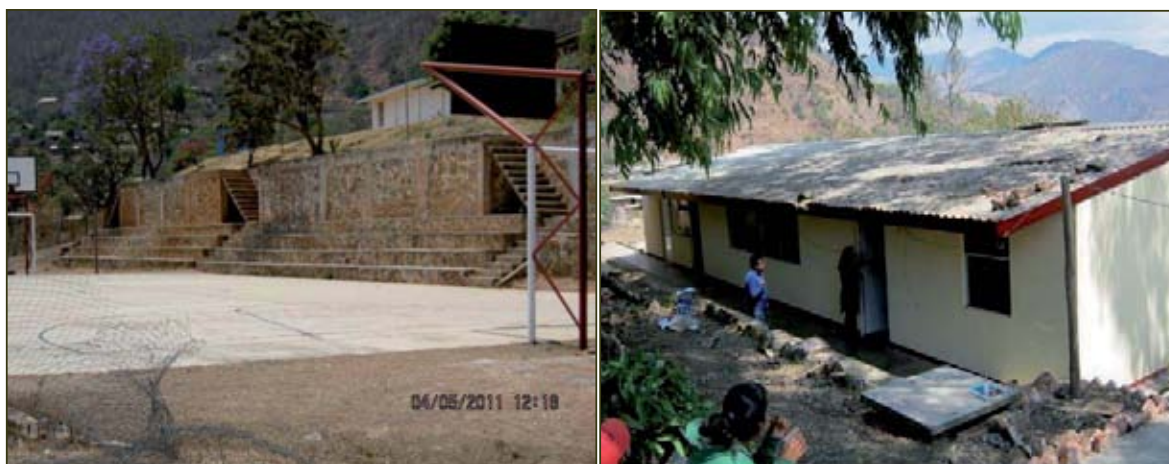
Imagen 23. Obras de infraestructura educativa inconclusas y poco adecuadas.
