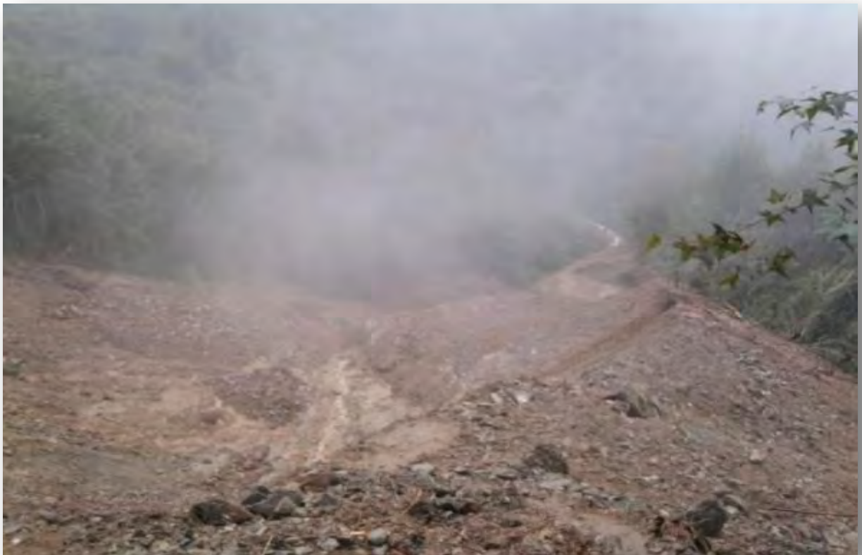
TRAMO SAN BARTOLOME YATONI-OTATITLAN DE MORELOS
