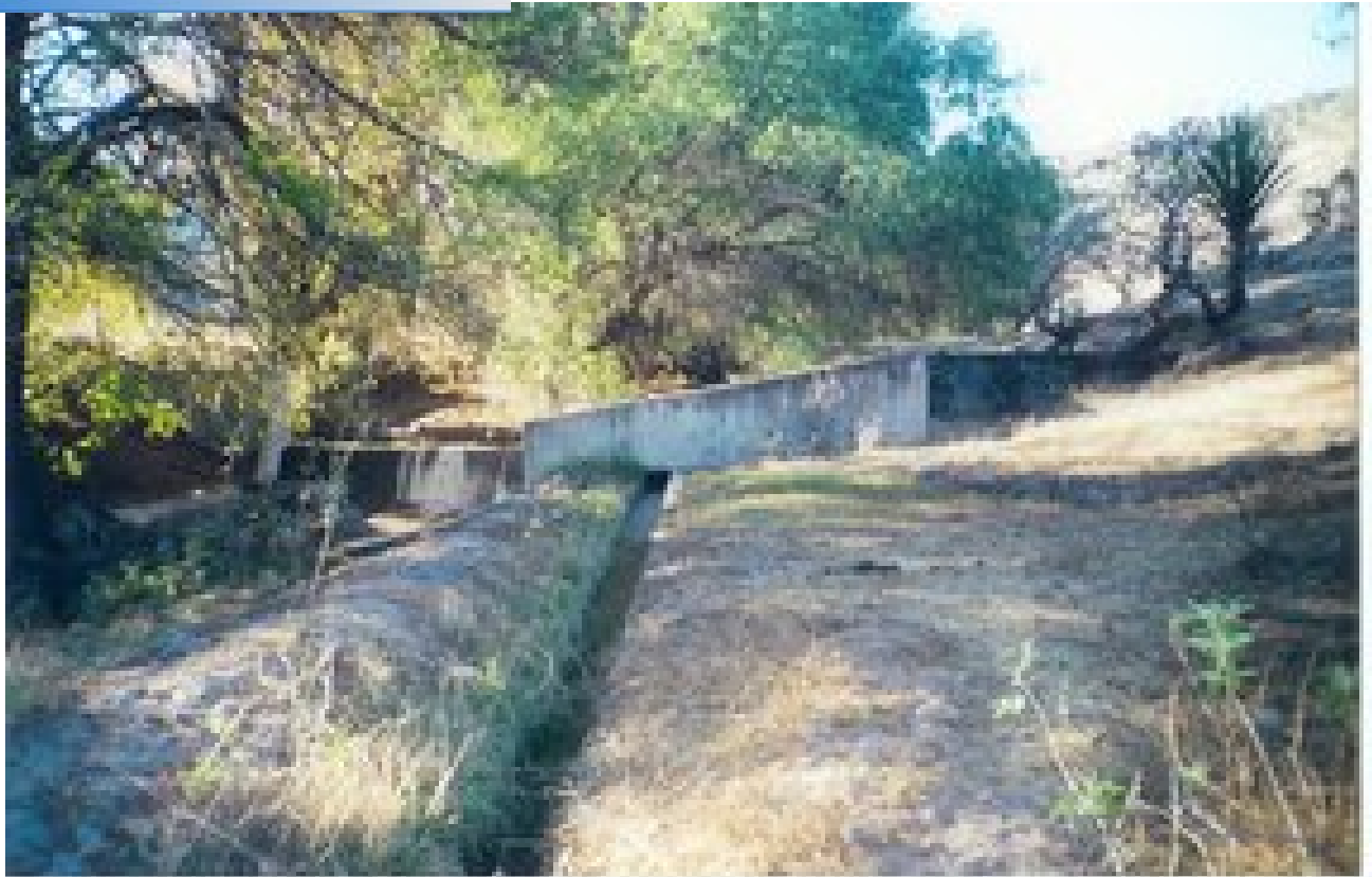
Derivación de agua del río mixteco y canales de riego revestido
